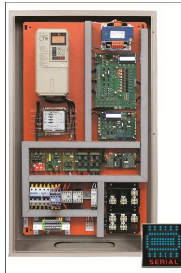
Figuras 4 e 5 - Quadro de Comando de um Elevador Elétrico do tipo Multiplexado ou Serial.
