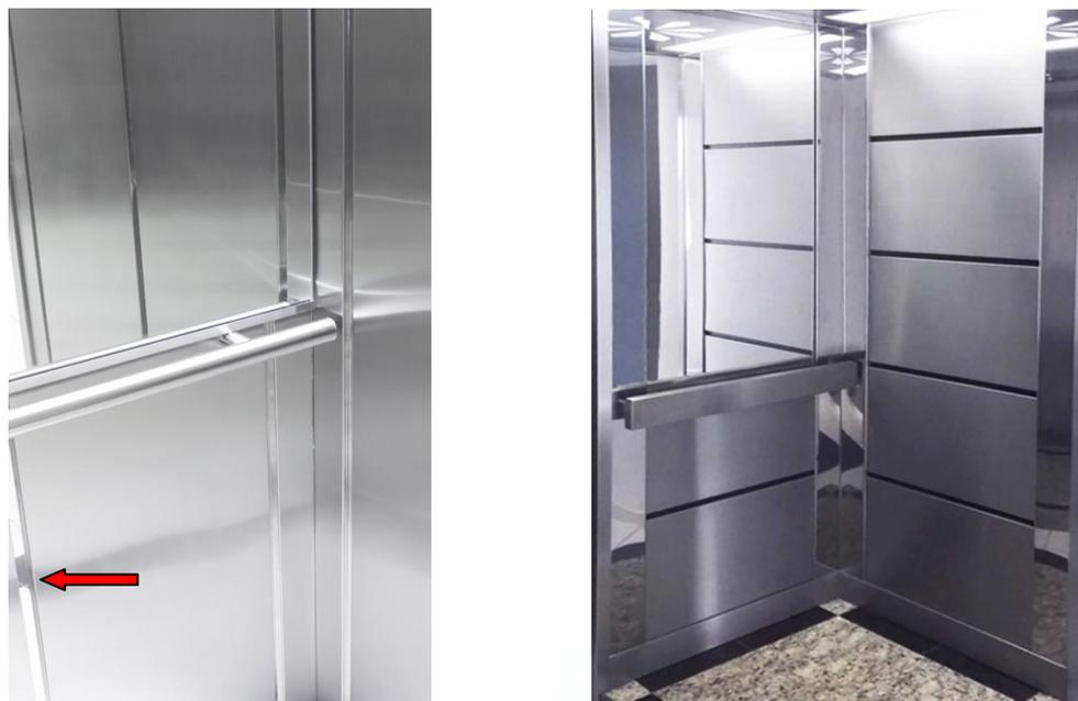
**Figuras 25 e 26** – No primeiro caso, exemplo de uma Cabina com Painéis Dispostos na Vertical, em Aço Inox Escovado com um Vinco de ligação entre os Painéis em formato retangular em Aço Inox Polido. No exemplo seguinte, uma Cabina com Painéis Dispostos Horizontalmente, em Aço Inox Escovado, com um Vinco de ligação entre os Painéis em formato retangular em Aço Inox Polido e Cantos Retos em Aço Inox Polido.
