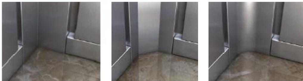
**Figuras 9, 10 e 11** - Cantos Retos (Ortogonais - Padrão), Cantos Chanfrados (Com ou sem iluminação) e Cantos Arredondados.
