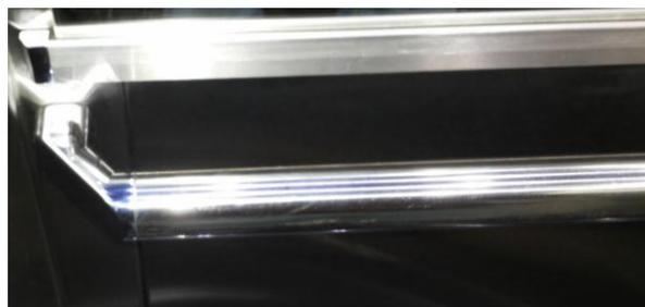
**Figuras 21 e 22** - Detalhes do Corrimão da Cabina do Tipo Redondo com Cantos Retos (Corrimão Padrão) e um Corrimão Redondo com Cantos Chanfrados.
