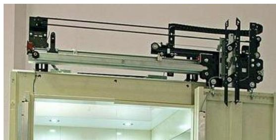
**Figuras 45 e 46** – Operador de Portas e Conjunto do Operador de Portas e Portas de Cabina.
