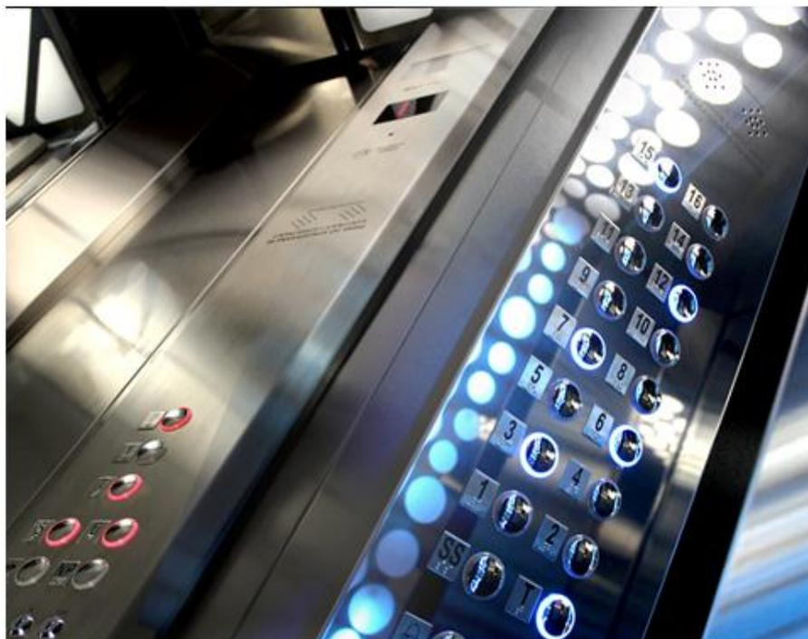
**Figura 31** – POC (Painel de Operações e Controle) da Cabina do tipo Totem com Botões de Chamado modelo NEO, Auto Iluminados na cor Vermelha ou Azul, com insertos de identificação em Braille e Displays Indicador de Posição por Segmentos.
