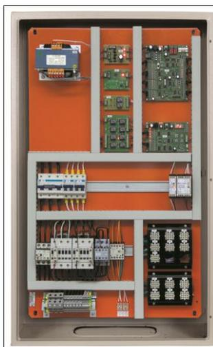
Figura 57 - Quadro de Comando de um Equipamento Hidráulico.
