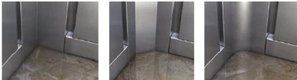
**Figuras 10, 11 e 12** - Cantos Retos (Ortogonais - Padrão), Cantos Chanfrados (Com ou sem iluminação) e Cantos Arredondados.
