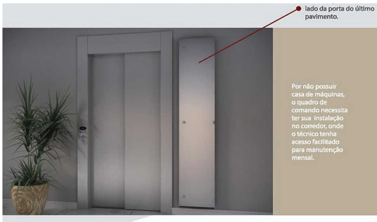
Figura 4 – Vista da Instalação do Quadro de Comando ao lado da porta de pavimento do elevador no último andar superior da edificação.
