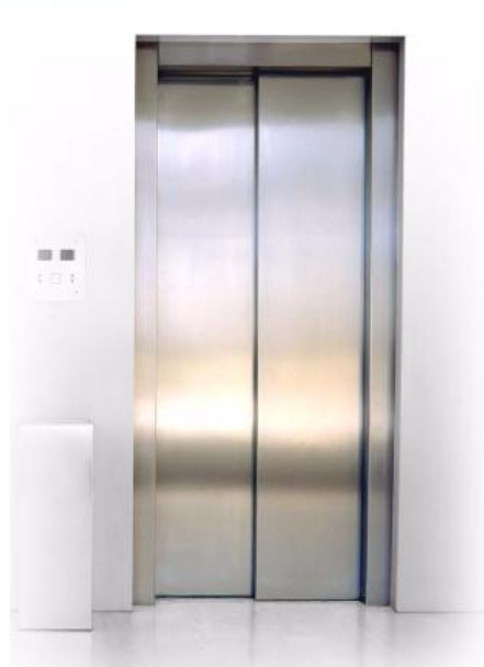
Figuras 46, 47 e 48 – Portas de Pavimento em Aço Inox - Automáticas Telescópicas Corrediça com Abertura Lateral (Frente e Verso).
