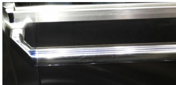
Figuras 20 e 21 - Detalhes do Corrimão da Cabina do Tipo Redondo com Cantos Retos (Corrimão Padrão) e um Corrimão Redondo com Cantos Chanfrados.
