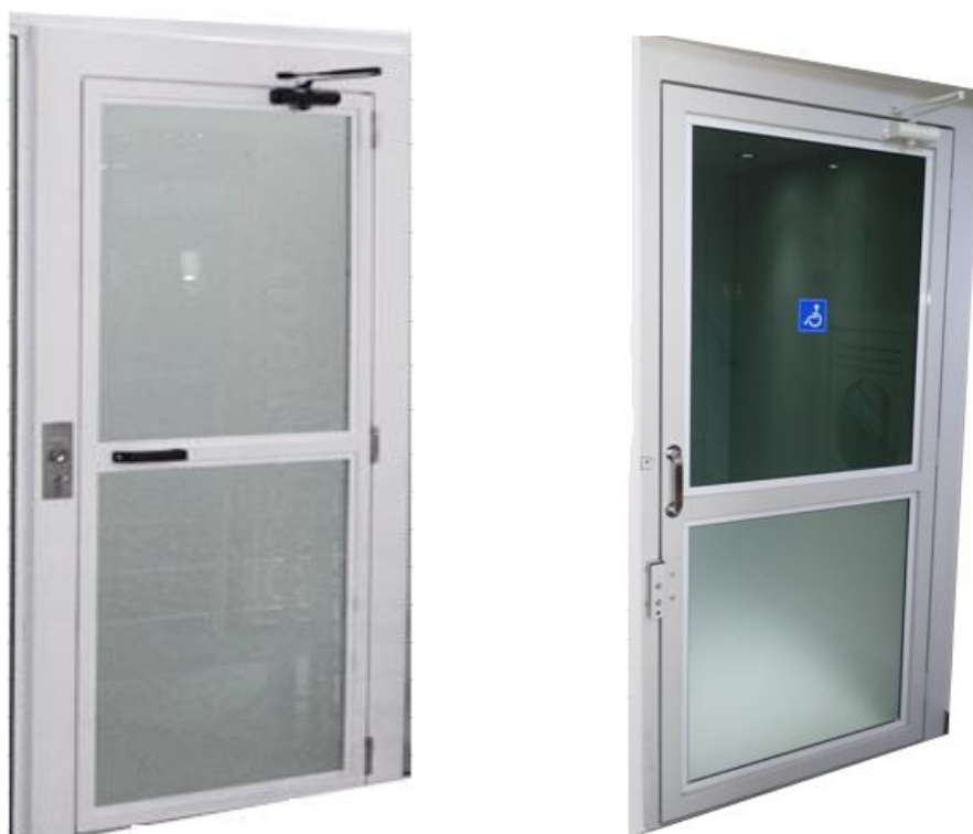
Portas com 2 (duas) Aberturas de Vidro com Aplicação de Película fosca em 1 e 2 Vidros.
