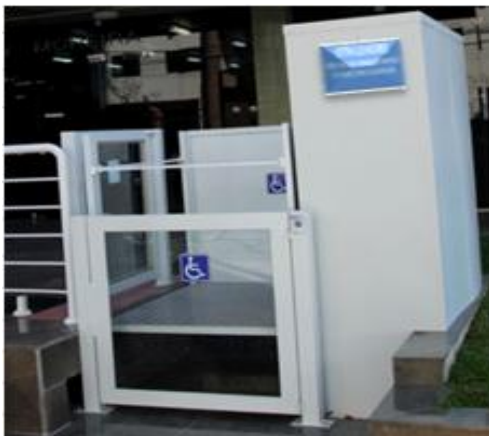
Cabina de Aço Carbono com Portas Adjacentes de Aço e Vidro.
